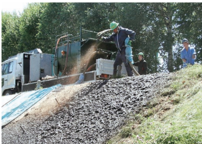
一般的に使用される施工機械での吹き付けが可能です。
